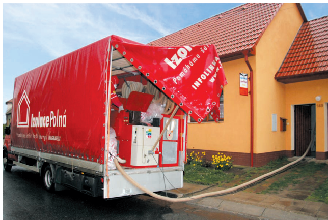
Foukání izolace hadicí z vozu před domem
