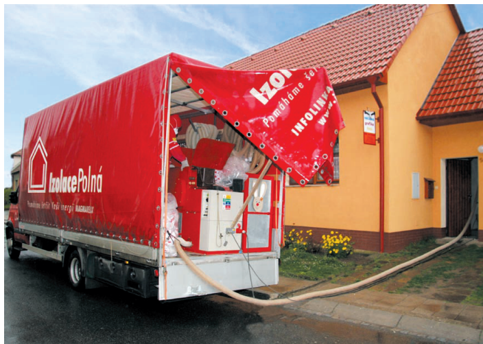
Foukání izolace hadicí z vozu před domem
