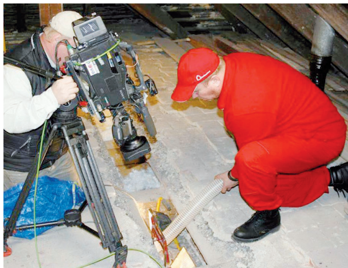
Při natáčení pořadu Rady ptáka loskutáka - zateplení dutiny trámového stropu
